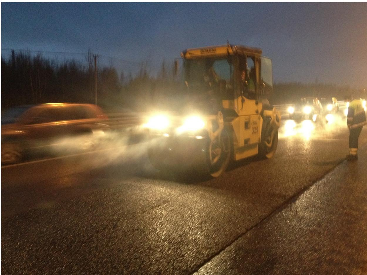
Рис.8 Укладка ЩМА-20 с модификатором «Dorflex ВА».
